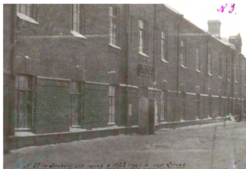
Рис. 4. Здание клуба 87-го полка в Военном городке. 1922 г. Ныне – неотребованное здание бывшей казармы Из открытых интернет-источников
