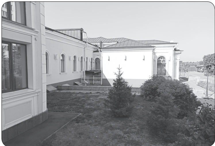
Фото 3. Центр изучения истории Гражданской войны (вид с востока). 3 августа 2020 г. Фото М. М. Стельмака Center for the Study of the History of the Civil War (view from the East). August, 3, 2020. Photo by M. M. Stelmak
